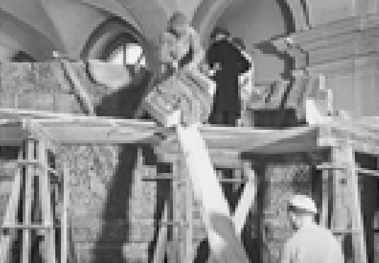
Museum für Islamische Kunst im Kaiser-Friedrich-Museum, Abbruch der Mschatta-Fassade, 1931–1932 / Museum for Islamic Art in the Kaiser-Friedrich-Museum, deconstruction of the Mshatta façade, Room II, 1931–1932 ©SMB-ZA, 2.11.-3235
