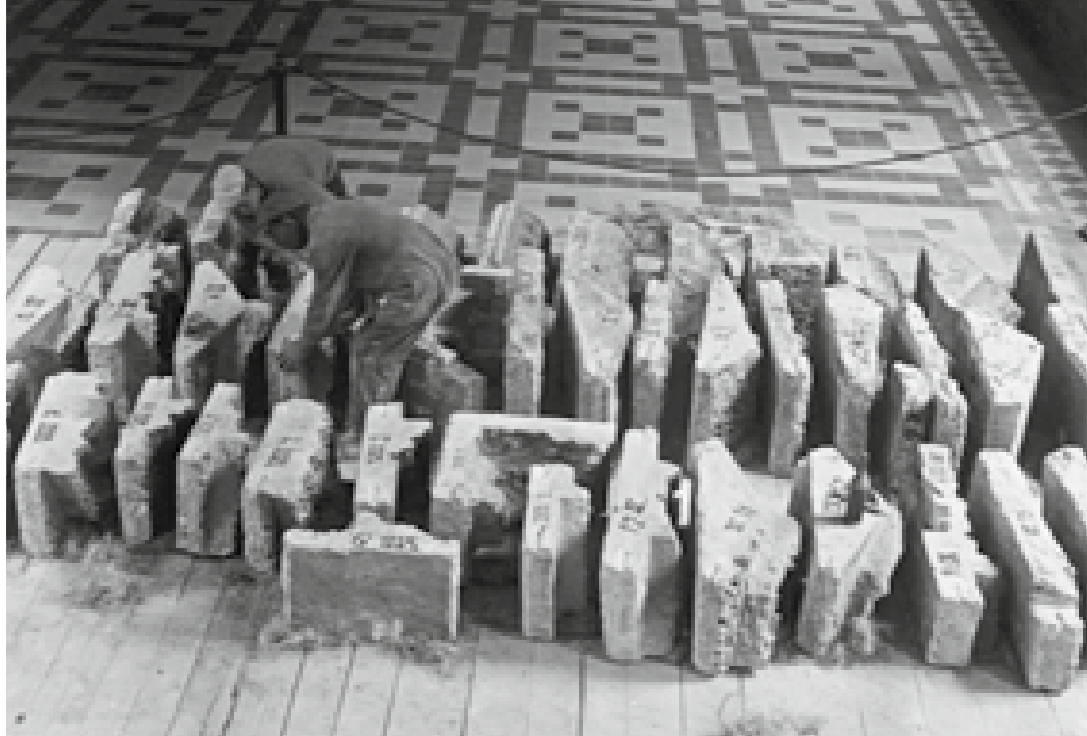
Museum für Islamische Kunst im Kaiser-Friedrich-Museum, Bauarbeiter während des Abbruchs der Mschatta-Fassade, 1931–1932 / Museum for Islamic Art in the Kaiser-Friedrich-Museum, workers during the deconstruction of the Mshatta façade, 1931–1932 ©SMB-ZA, 2.11.-3240
