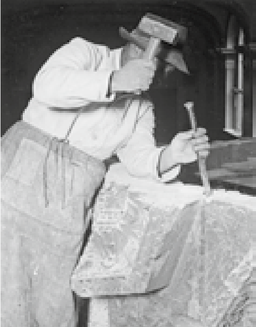
Museum für Islamische Kunst im Kaiser-Friedrich-Museum, der Restaurator Friedrich Bachor während des Abbruchs der Mschatta-Fassade, 1931–1932 Museum for Islamic Art in the Kaiser-Friedrich-Museum, conservator Friedrich Bachor during the deconstruction of the Mshatta façade, 1931–1932 ©SMB-ZA, 2.11.-3237
