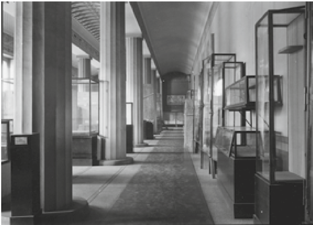
Schutzmaßnahmen im Historischen Saal im Neuen Museum, 1939–1941 Precautions in the historic hall of Neues Museum, 1939–1941 ©SMB-ZA, 1.1.3.-2969
